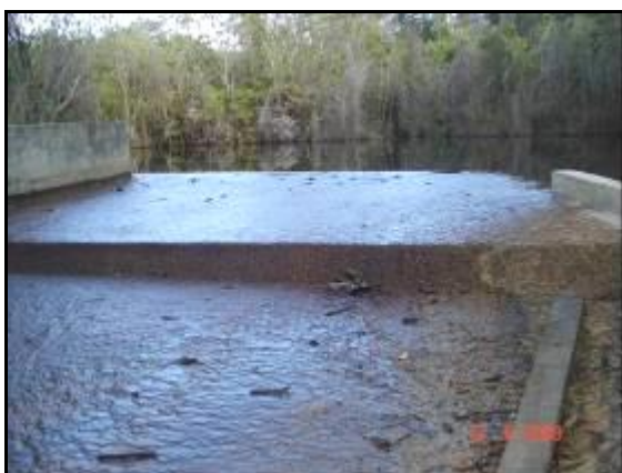
Figura 2 - Barragem para Captação de Água Cabeça de Veado I
