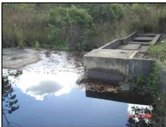
Figura 4 – Barragem e Canal de Derivação para Captação de Água Cabeça de Veado II
