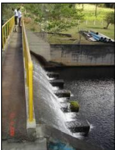
Figura 6 – Barragem para Captação de Água Cabeça de Veado IV
