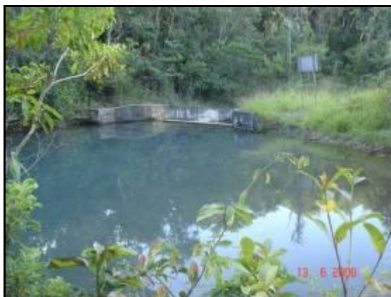
Figura 5 – Barragem e Canal de Derivação para Captação de Água Cabeça de Veado III
